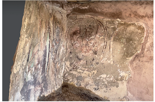
写真19 石積み構造物の内部（三次元データ）
