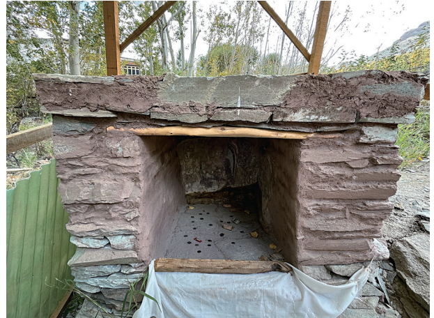
写真14 構造物の内部空間
