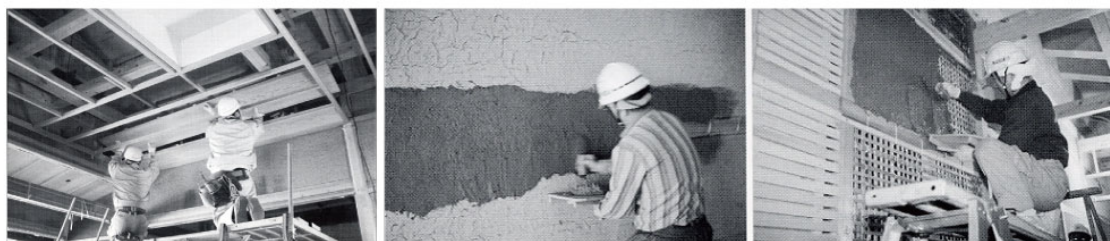
図 ※18 京都迎賓館の施工 左から数奇屋大工・左官（中塗り土を塗る） ・竹小舞に荒壁土を塗る）
