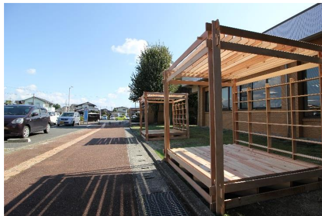
図 5-37. モバイル型「お堂」外部の設置状況
